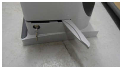
Motor in ontgrendelde toestand (manuele bediening)
